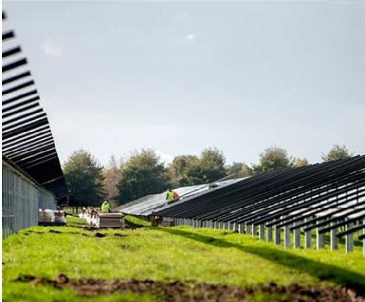
Budowa farmy PV Stawiec
